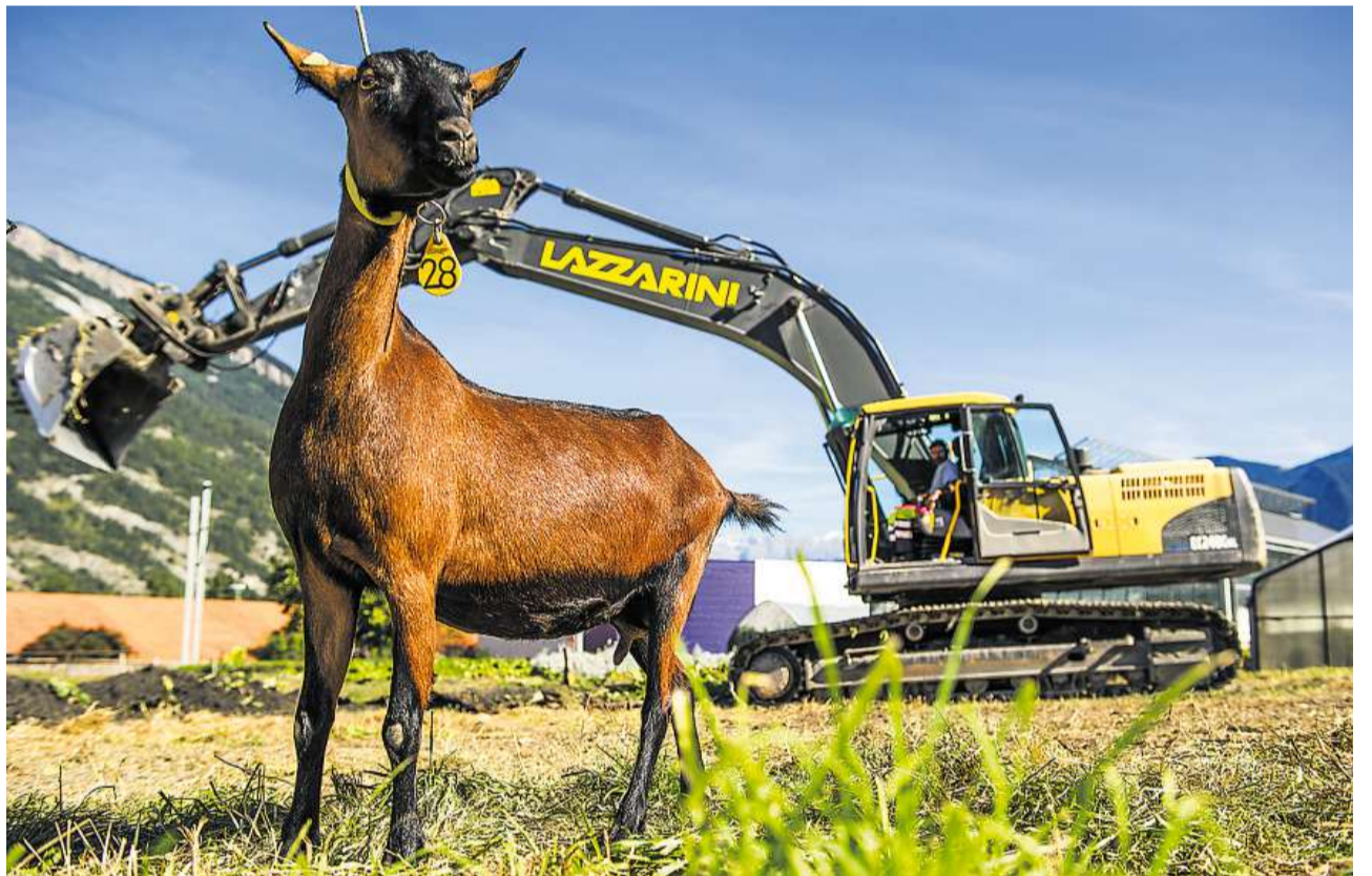
Neues Zuhause für 150 Ziegen: Der Bau eines neuen Ziegenstalls und einer Hofsennerie hat gestern begonnen – im Sommer 2014 sollte der Stall dann bezugsbereit sein. Bild Yanik Bürkli
